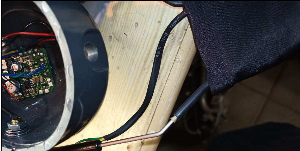
Bild-05 – Schrumpfschlauch über Kabel:
